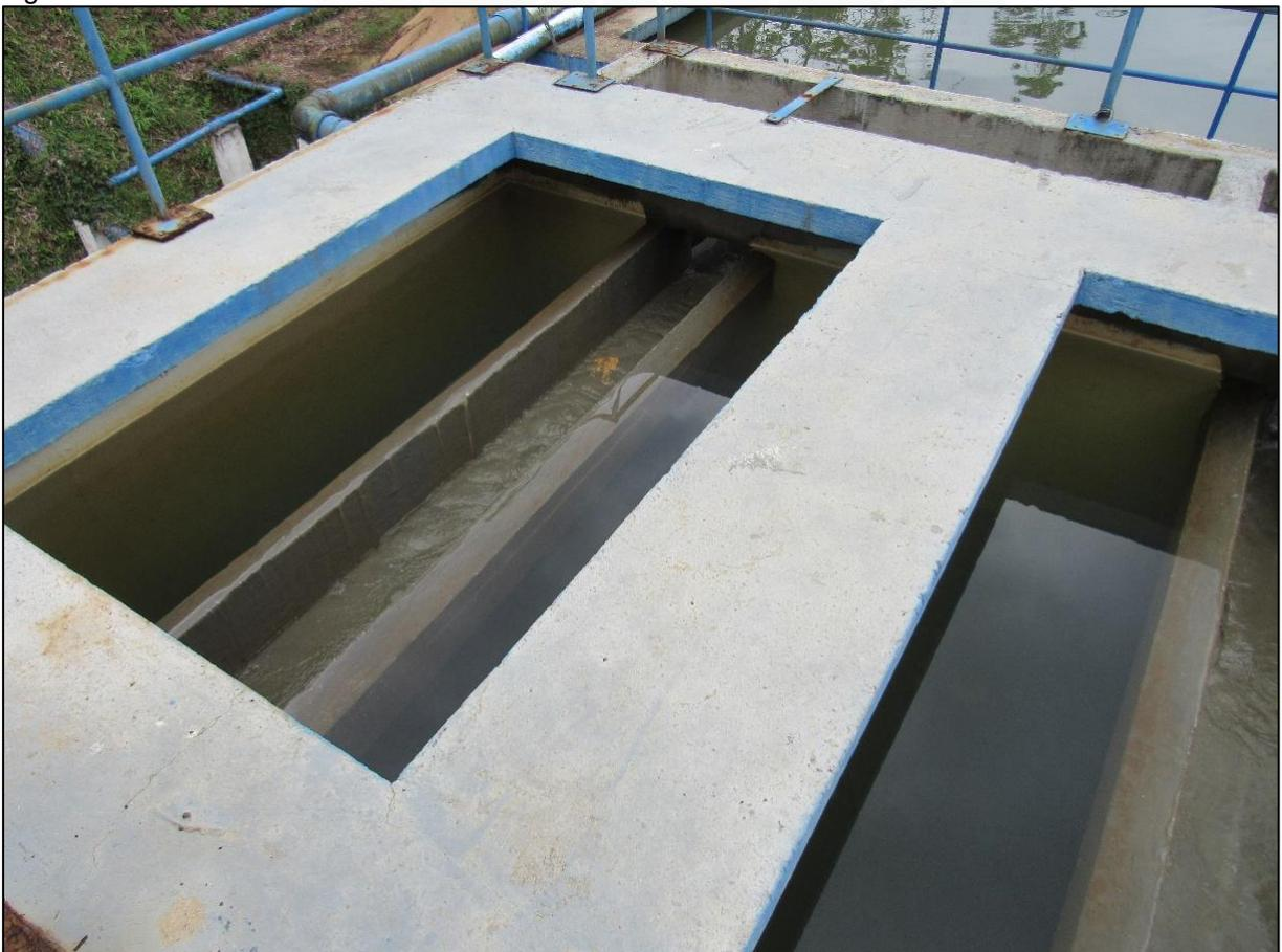
Figura 25: Reservatórios para armazenamento da água utilizada na retrolavagem dos filtros rápidos.
