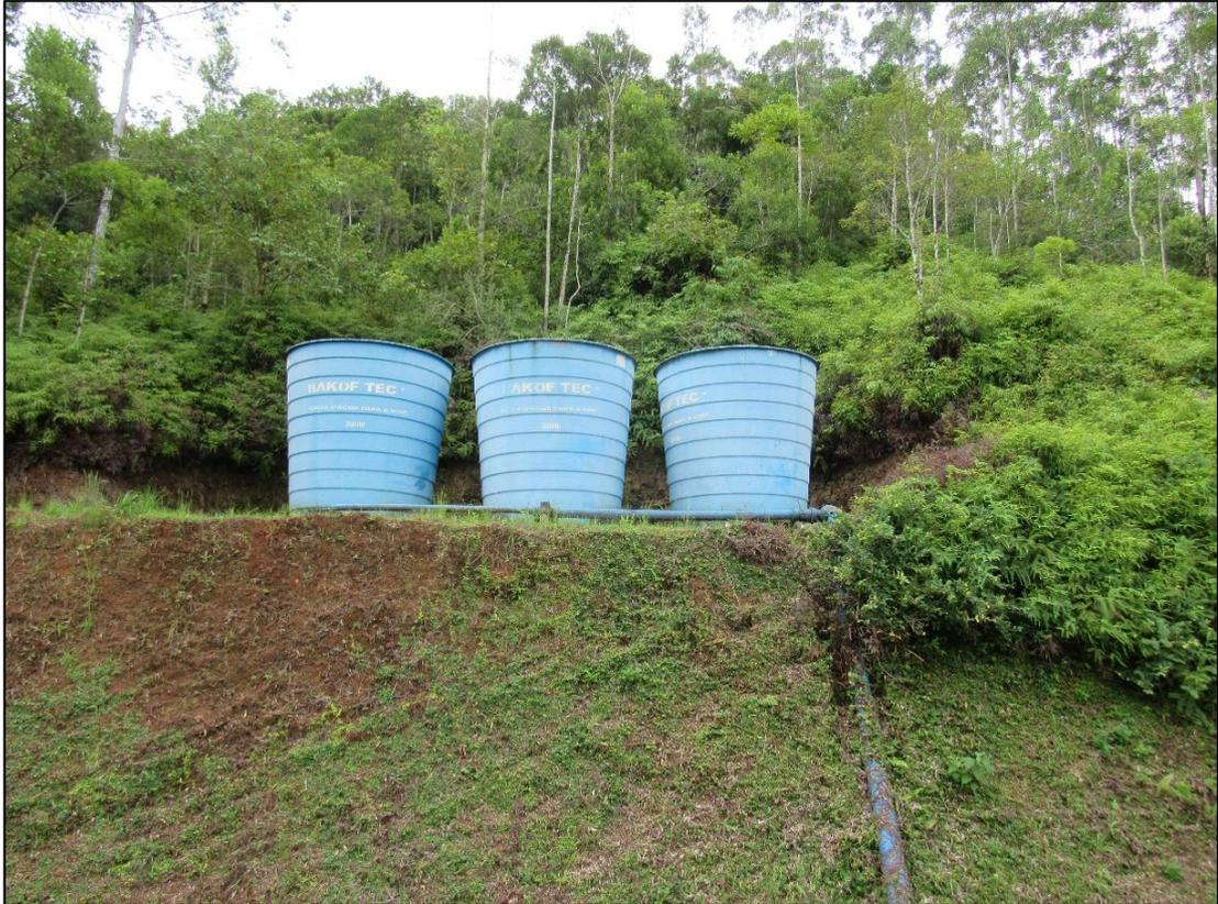
Figura 26: Sistema de filtros lentos de fluxo descendente.
