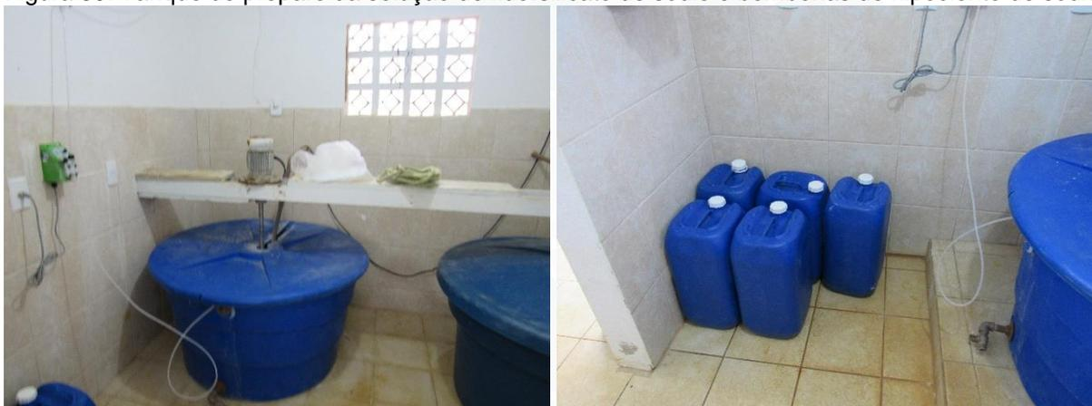
Anexo à casa de química há um espaço destinado ao monitoramento da qualidade da água (Figura 40), onde são coletadas amostras e realizadas as análises de cloro livre, flúor, turbidez, cor e pH. As demais análises são realizadas por laboratório terceirizado.
