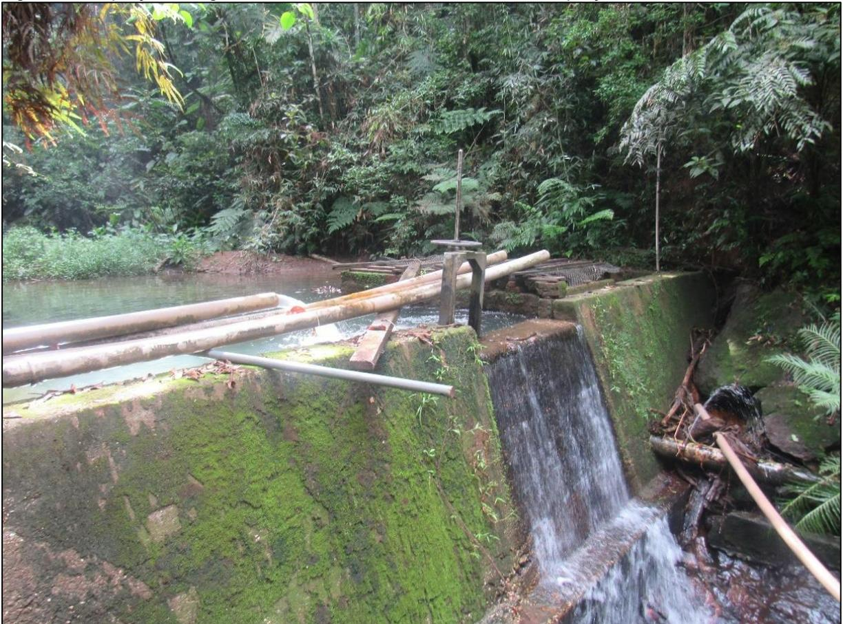
Figura 23: Captação de água localizada no Ribeirão da Vasca – Captação 2.
